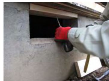
上端(土台下)に木材取付
