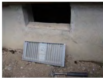
開口部のモルタルを平滑にするダンパーに引っかからないように
