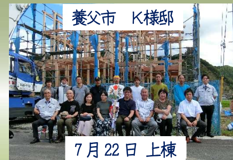
養父市 K様邸 7月22日 上棟 養父市K様邸は、7月に上棟を迎える事が出来ました。10月下旬の完成に向けて施工して参ります。
